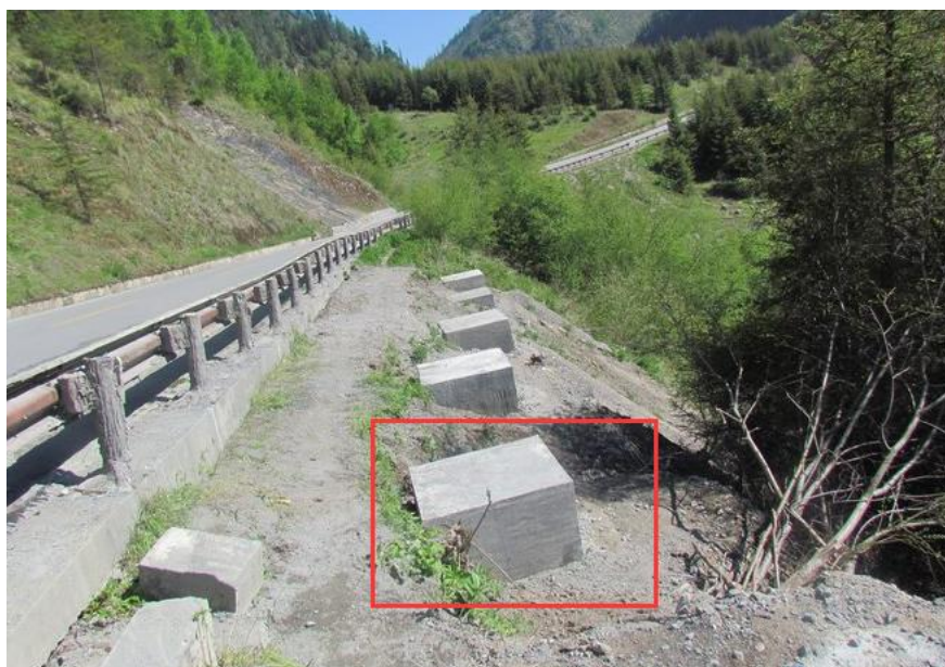
Protuklizni piloti (svi ispod terena)
